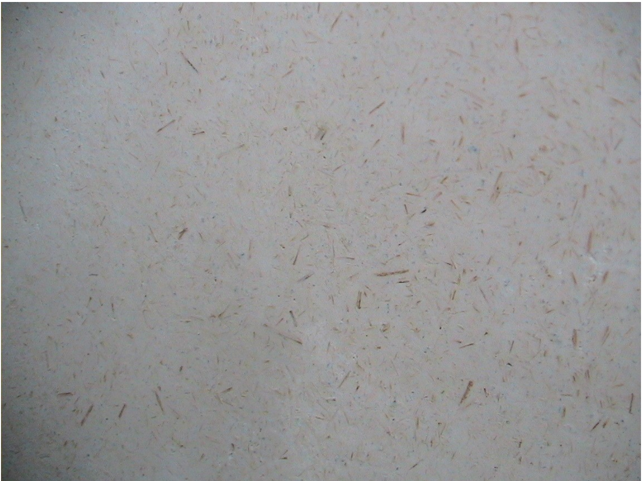
Illustration 10: détail enduit chanvre
