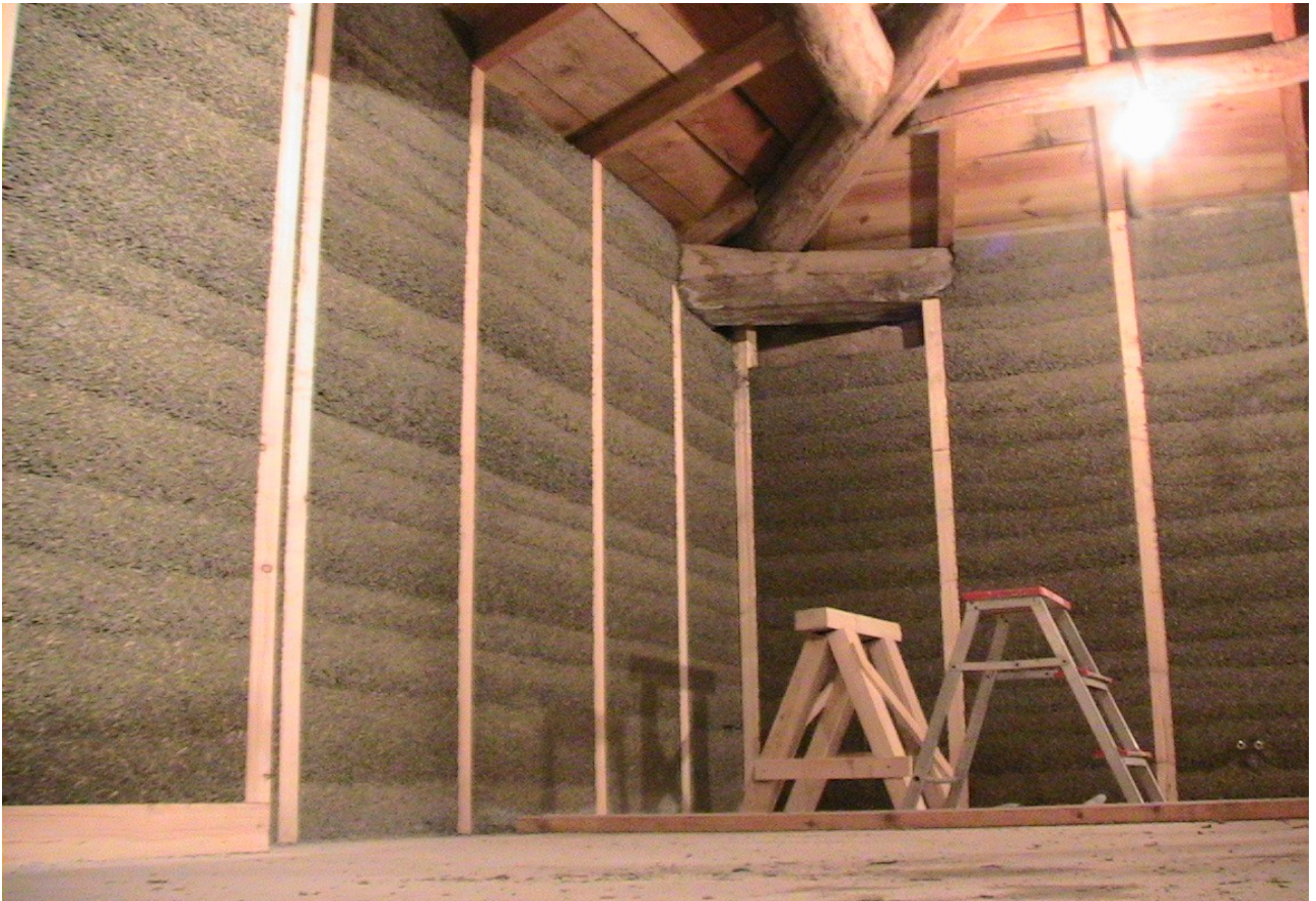
Illustration 8: doublage de mur avec ossature apparente
