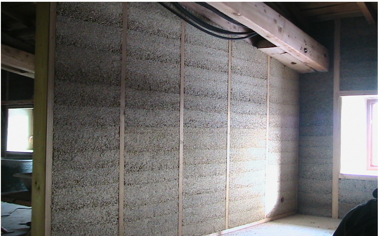
Illustration 9: Cloison banchée avec ossature apparente
