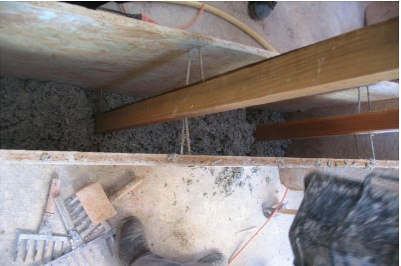
Illustration 6: coffrage pour cloison
