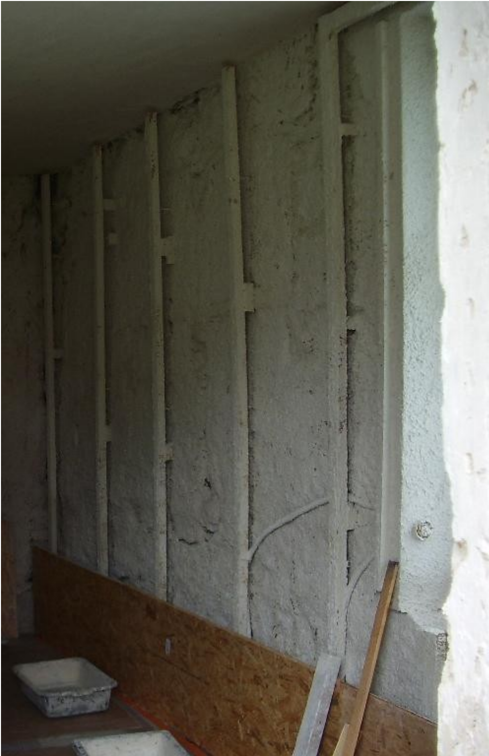
Illustration 5: doublage de mur par banchage
